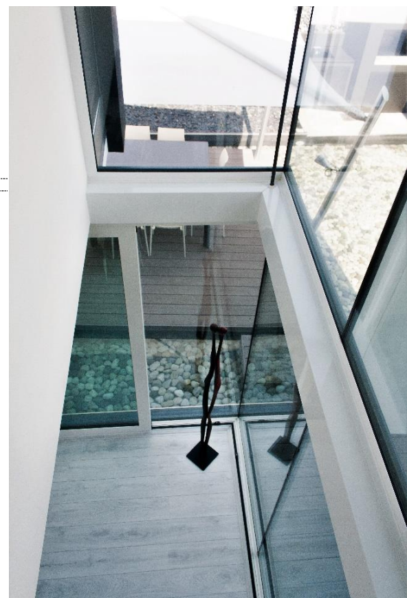
Fotografia del tirante sullo spigolo della sala da pranzo. Foto: Walter Menegaldo per "Vista Casa" n.70/2015.
