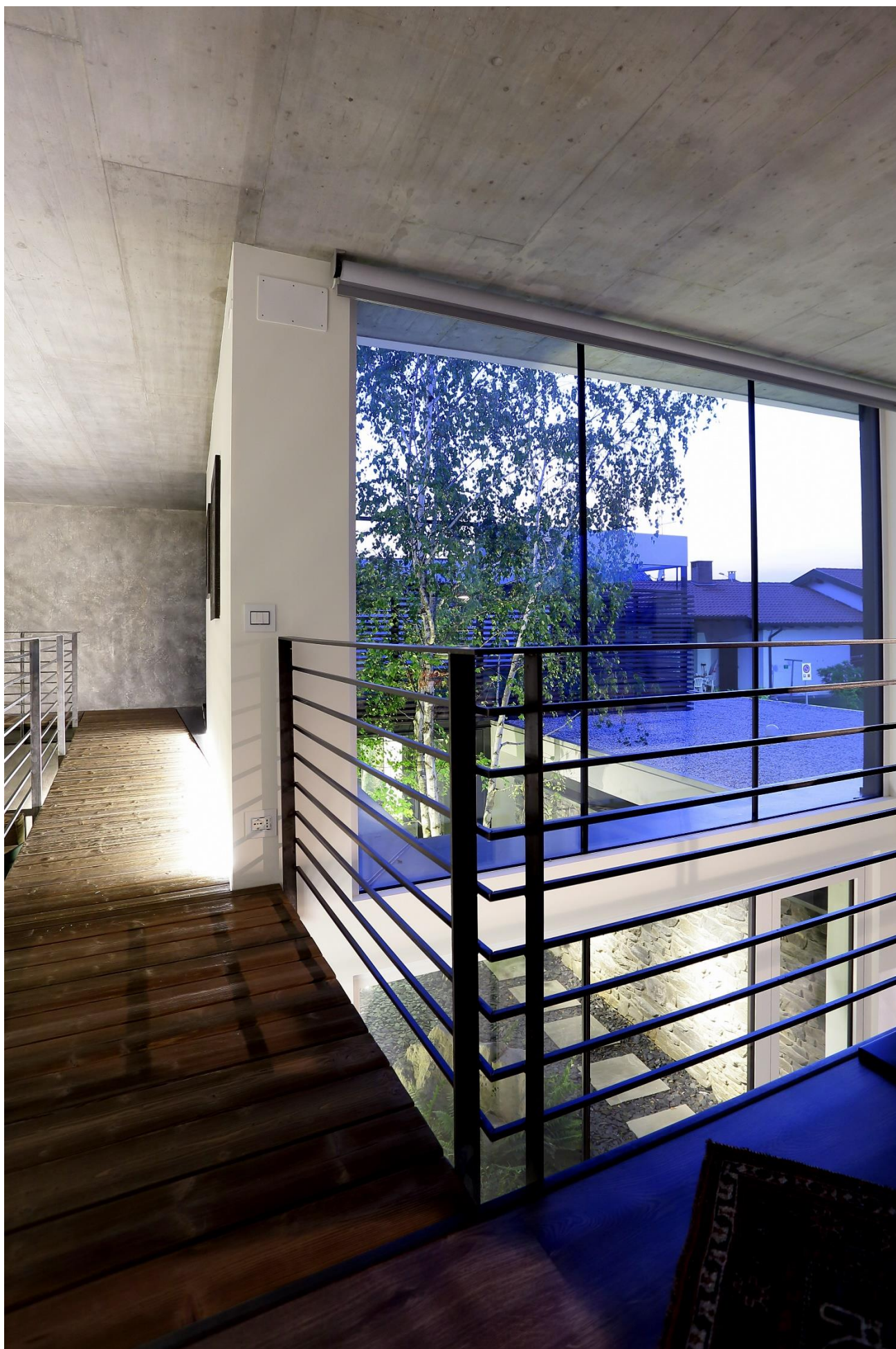
Fotografia del ballatoio a vista sul soggiorno del primo piano che congiunge le camere dei ragazzi e quella degli ospiti, attraversando da Ovest a Nord-Est la casa. Si affaccia sul giardinetto interno per mezzo di ampie vetrate. Foto: Walter Menegaldo per "Vista Casa" n. 70/2015.
