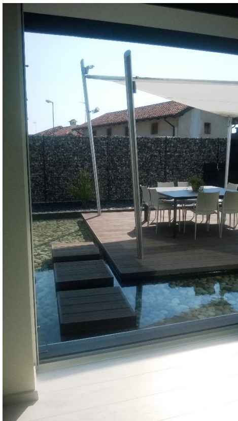
Passaggio pedonale sull'acqua costituito da piccole piattaforme che sembrano galleggiare e che conducono alla piattaforma più grande (zattera), che ospita un tavolo. Essa è coperta da una tenda a forma di vela sorretta da pali metallici obliqui. Foto: Arch. Guarneri, 2015.
