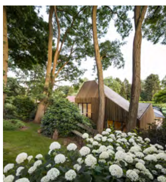
Extension d'une maison 90m 2 /extension of a 90-m 2 house - livré/delivered 2015 - Waterloo (be) - Privé
