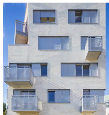
PMI + 81 logements/81 apartments - livré/delivered 2016 - Créteil (94) - Valophis
