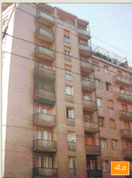
FOTO 4A LA FACCIATA PRIMA DEI LAVORI CON L'ORIGINALE RIVESTIMENTO A TESSERINE
