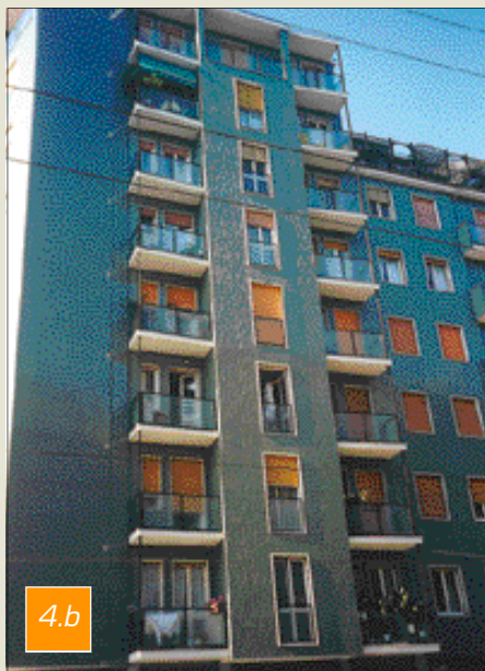
FOTO 4B DOPO L'INTERVENTO CON IL NUOVO RIVESTIMENTO IN CLINKER
