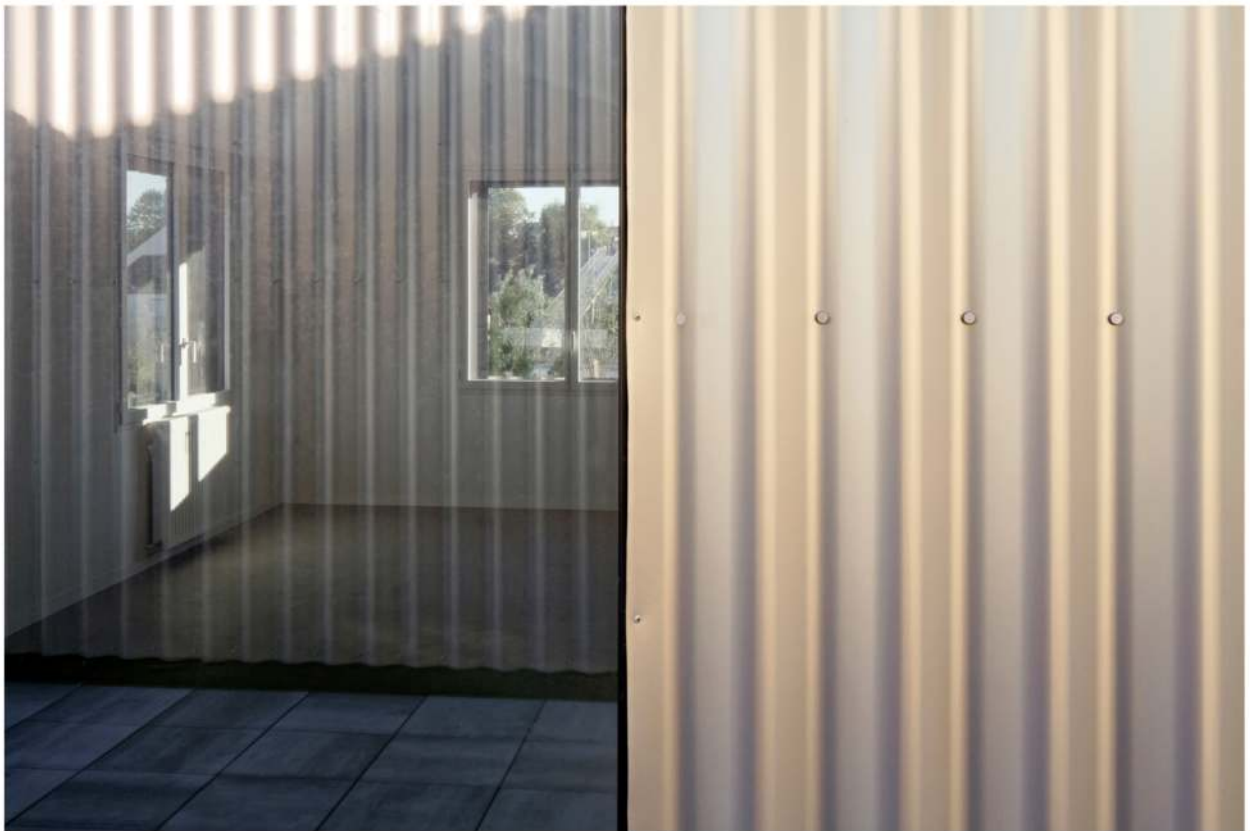
Garenne : allée du bois de la garenne, (page ci-contre)
