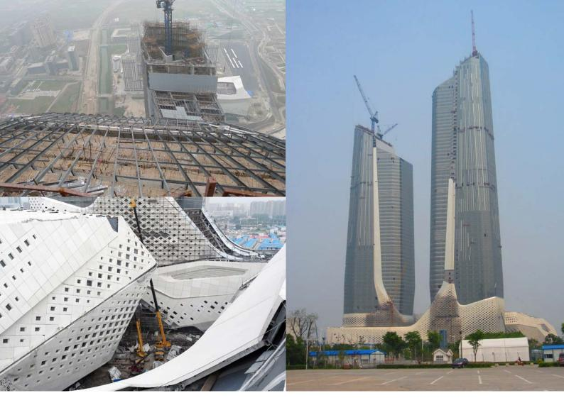
由此需要专门开发这20,000多块造型不一的幕墙板块数据包,如果没有参数化工具将不可能实现这一过程。本项目的幕墙承包商采用了与建筑设计师一致的3D模型平台,便于建筑师直接将其生成的数据输入承包商的制备流程,从而实现这一庞大项目的"大规模定制",因为制备参数可以直接遵循建筑师已经制定好的建筑外表皮参数,确保所有与典型矩形元件存在偏差的构件公差处于承包商生产设备的约束范围内。
