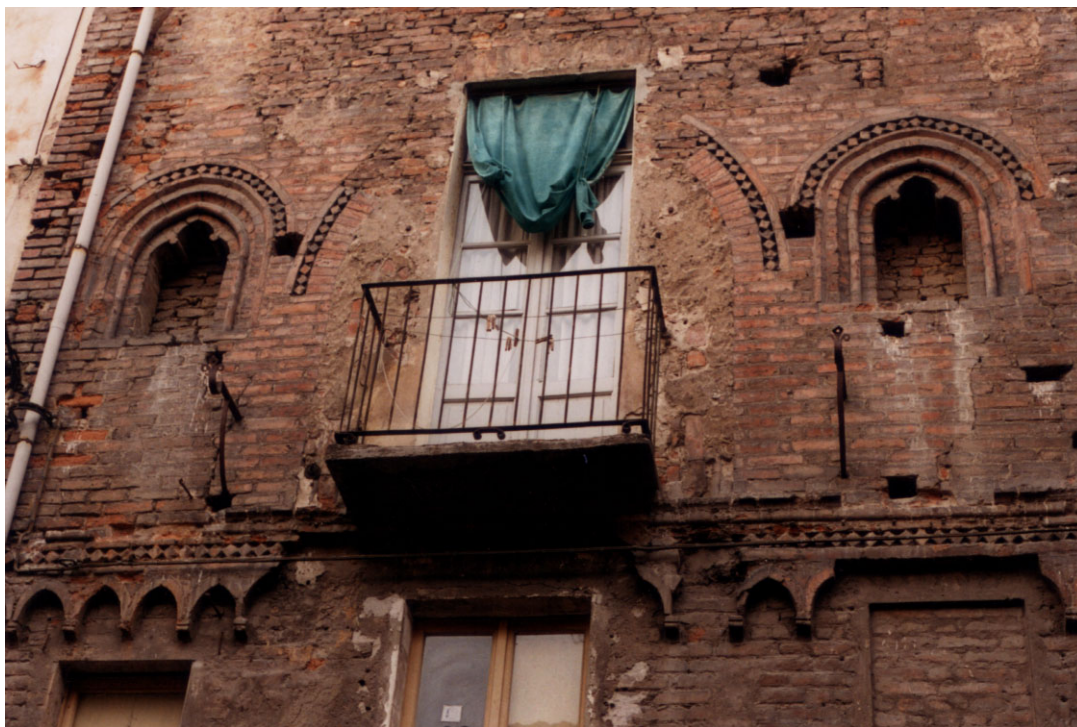
L'ospedale di Santa Croce di Moncalieri ( ante 1351). Le due aperture, forse destinate allo smaltimento dei fumi dei bracieri, accanto alla grande finestra centrale.
