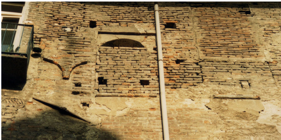
L'ospedale di Santa Croce di Moncalieri. A sinistra, murato, uno dei merli del coronamento originario.
