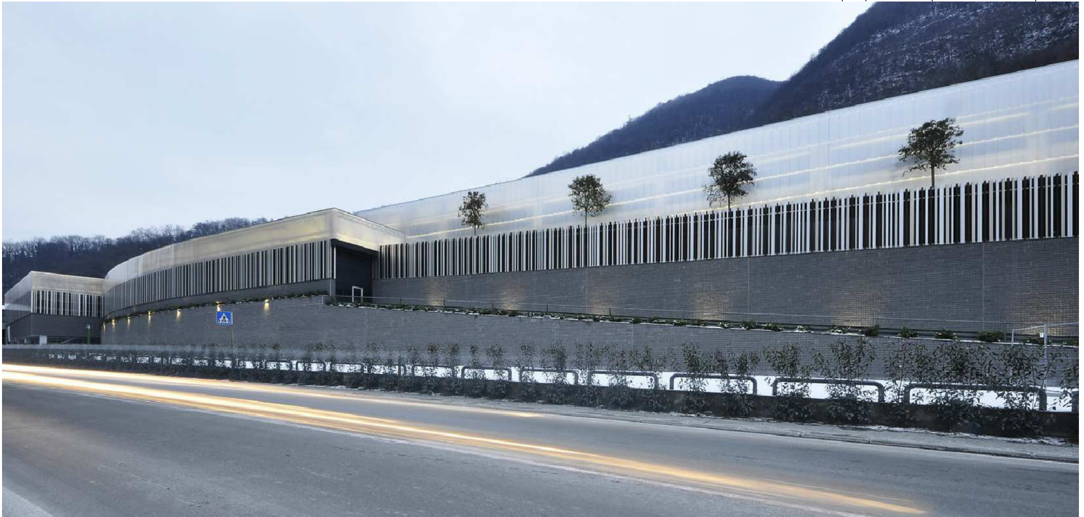
Veduta del fronte principale con la rampa di accesso alla zona produttiva
