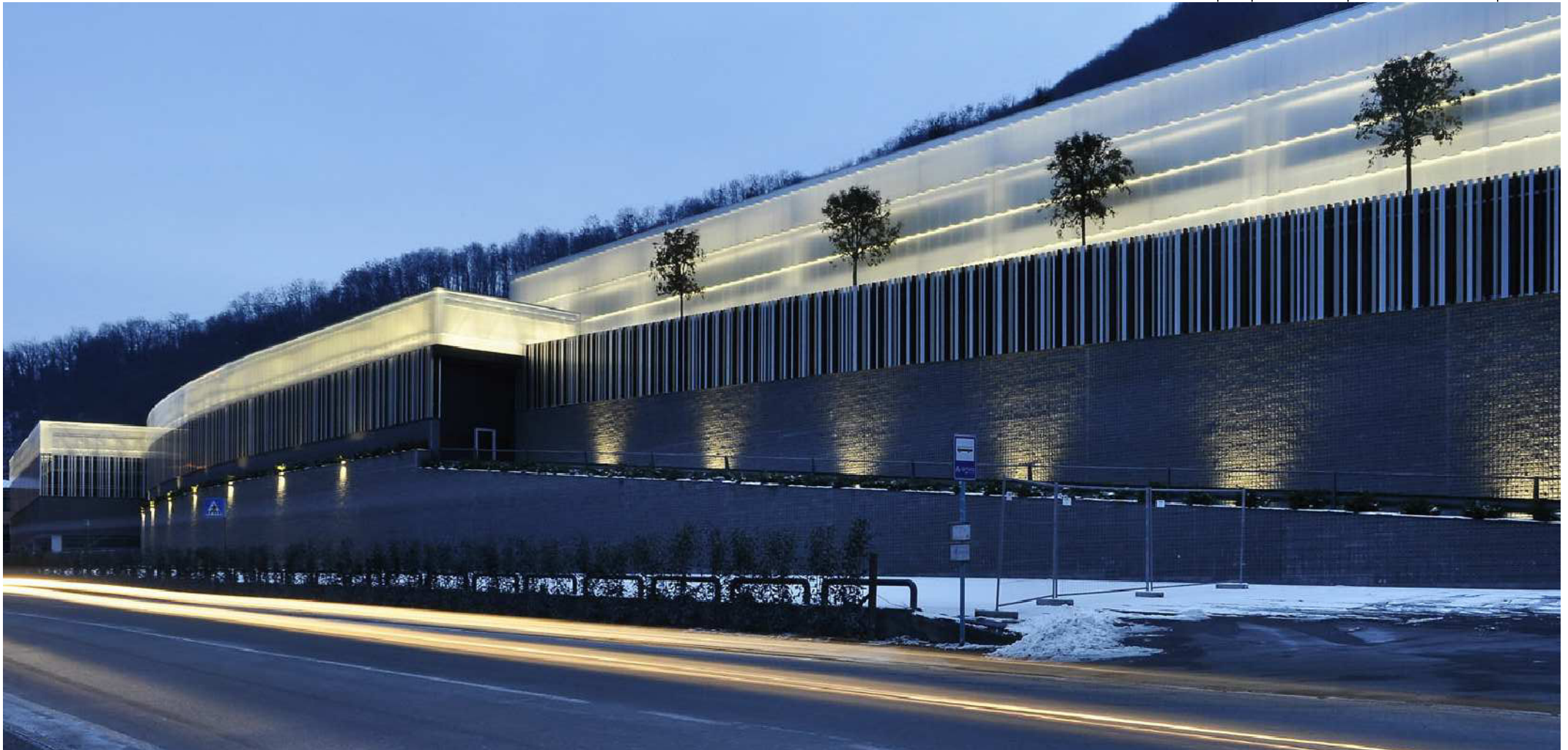
Veduta notturna del fronte principale con la rampa di accesso alla zona produttiva
