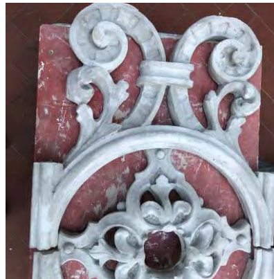
Figura 7: fase 1 - realizzazione del negativo in cantiere
