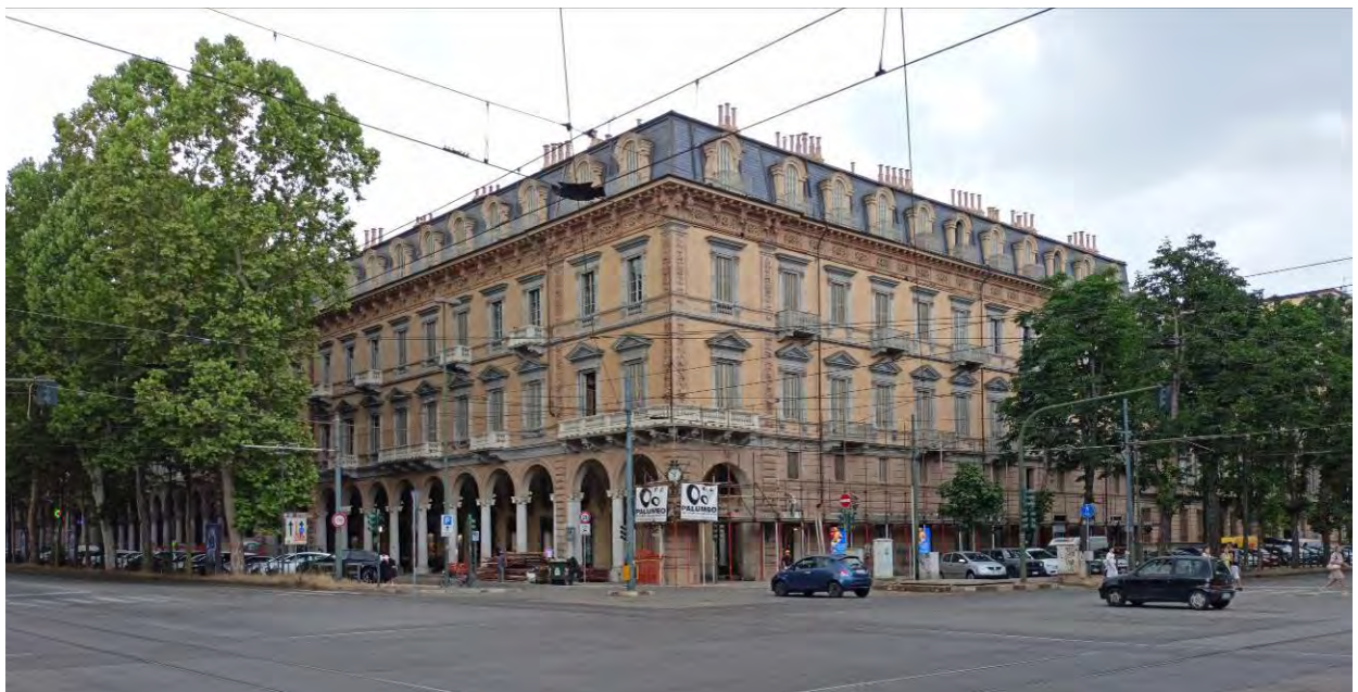
Figura 5: ad intervento quasi concluso - 23 aprile 2022
