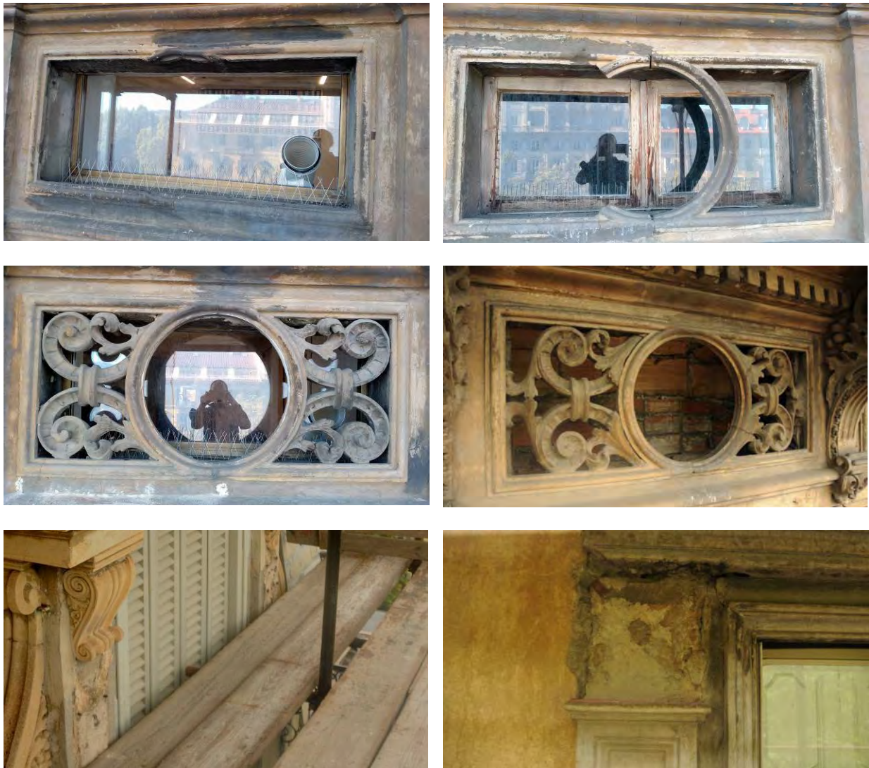
Figura 6: elementi modellati mancanti
