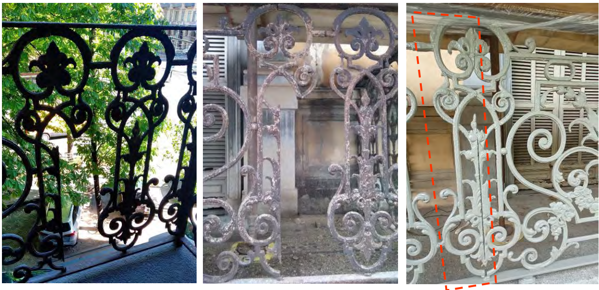
Figura 10: a) elemento mancante, b) elemento rimosso per campione c) elemento nuovo in opera
