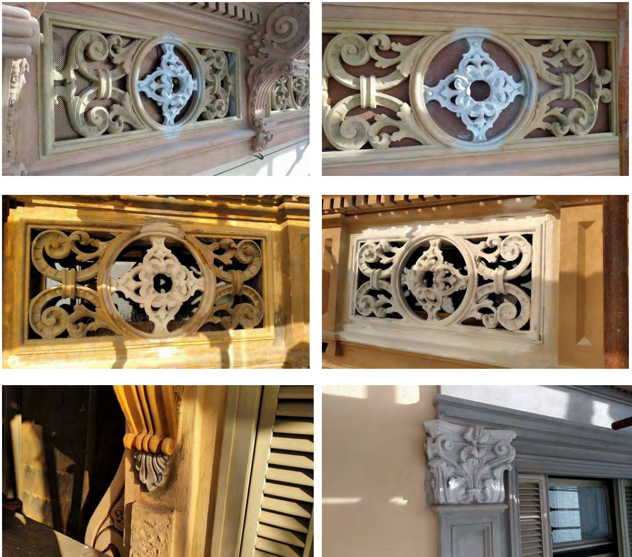
Figura 9: calchi messi in opera
