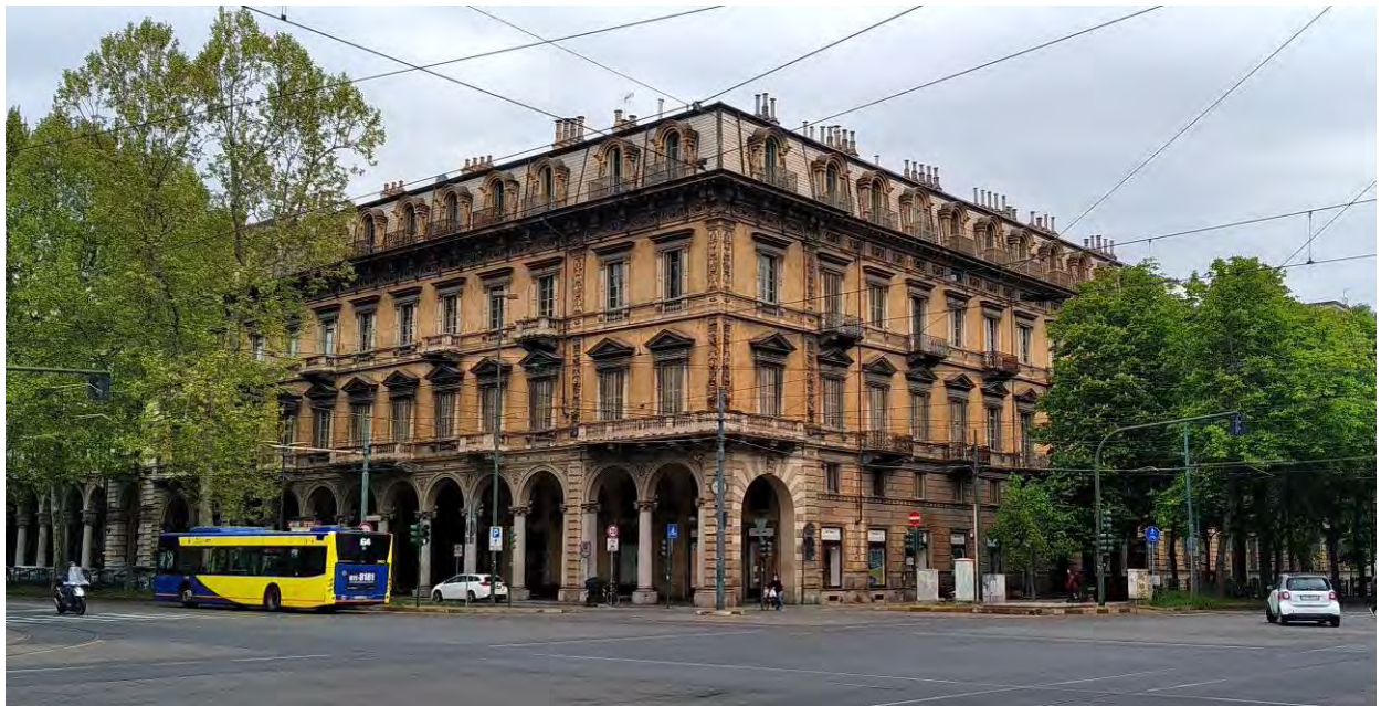
Figura 4: prima dell'intervento - 10 aprile 2021
