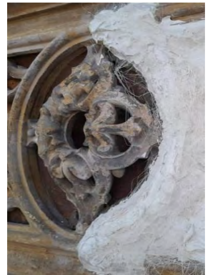
Figura 7: fase 1 - realizzazione del negativo in cantiere
