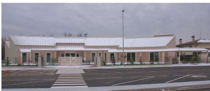
Foto n. 5 In inverno, un porticato lungo il lato Nord, protegge la parete dagli effetti dei venti, della pioggia battente e della neve.
