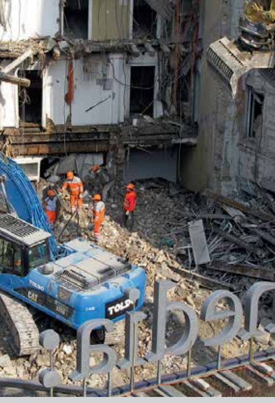
Der Abriss der Altbauten erfolgt vom Februar bis März 2011.
