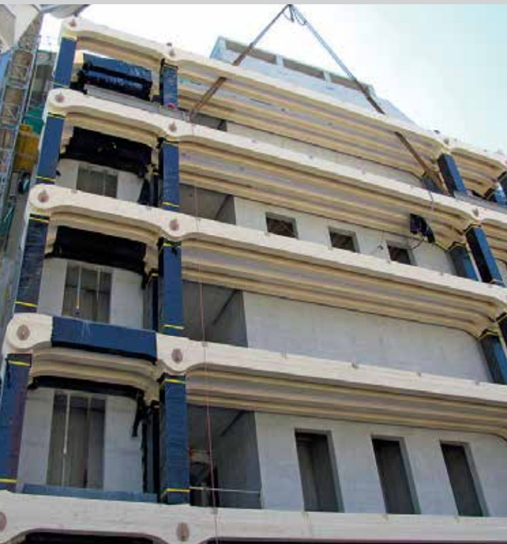
Ab April 2012 wird die Holzkons- truktion zusammengebaut.
