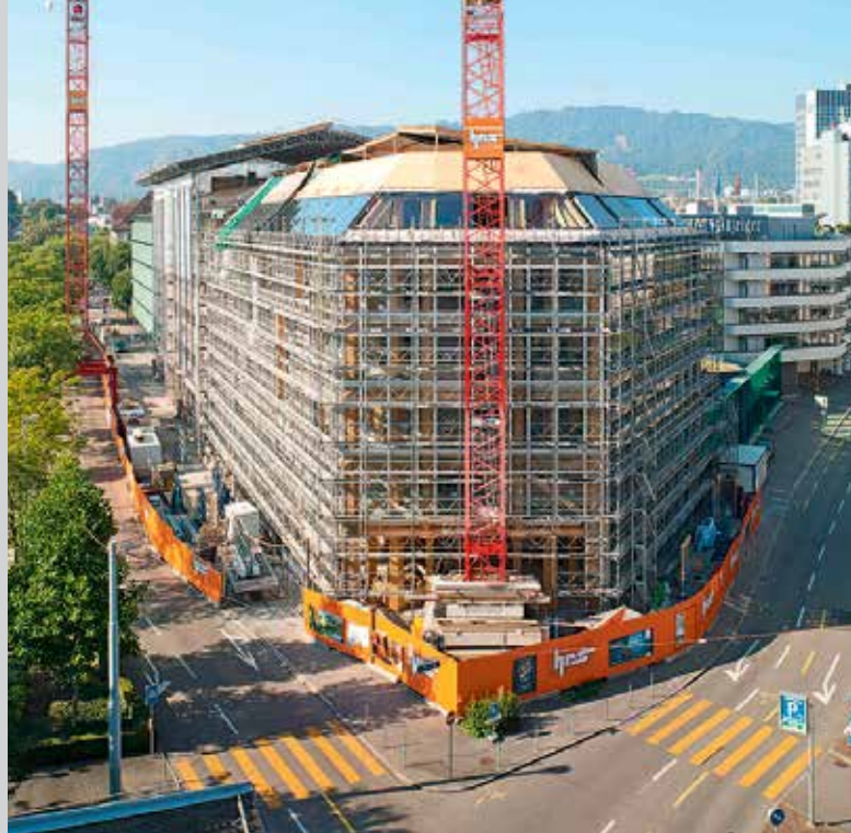
Die Fassade wird im Oktober 2012 geschlossen.
