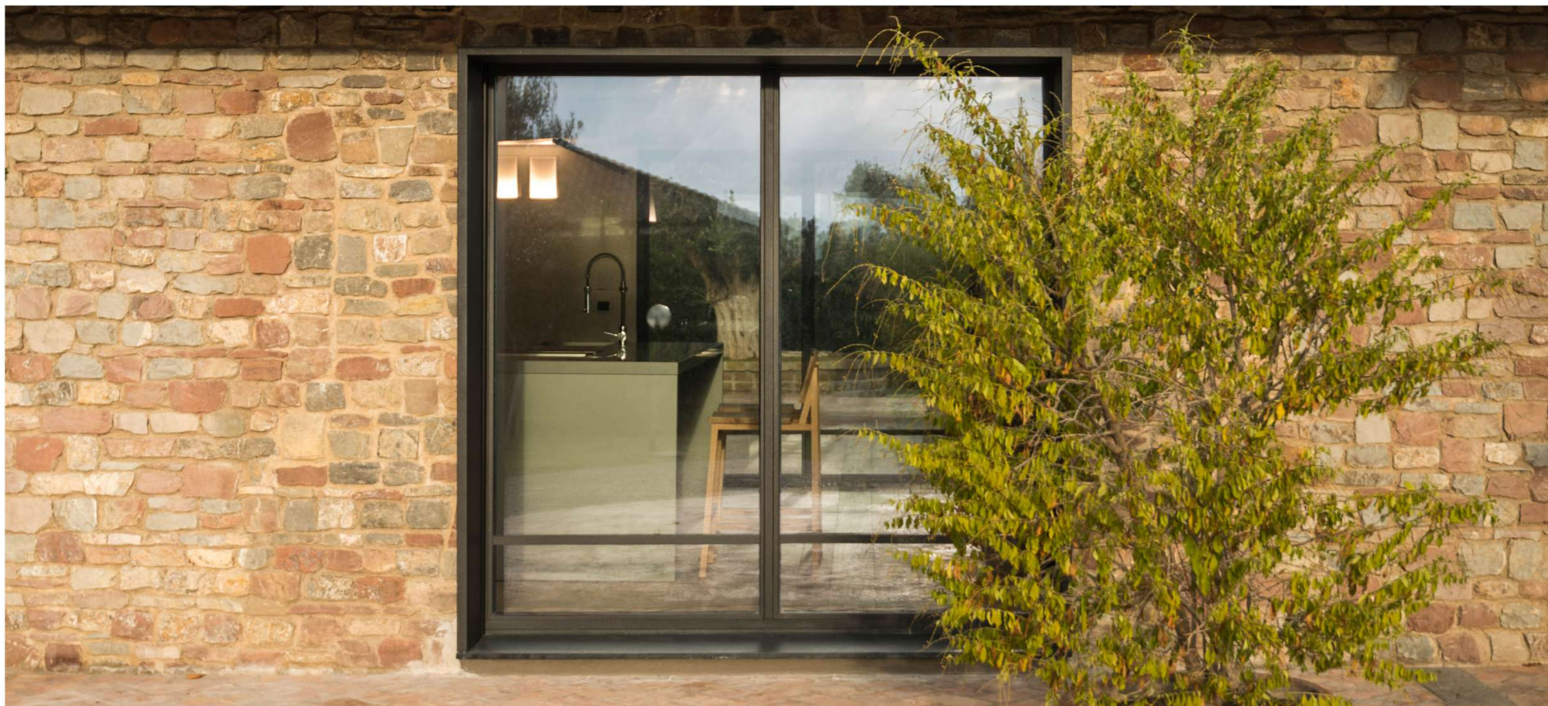
_studio di facciata e degli infissi esterni su disegno relizzati da Secco Sistemi
