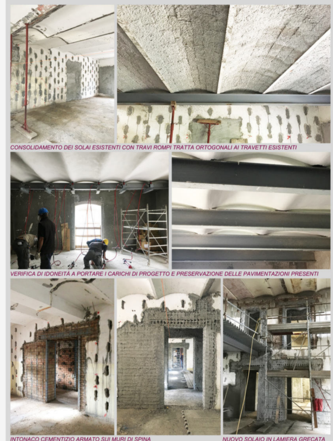
INTONACO CEMENTIZIO ARMATO SUI MURI DI SPINA NUOVO SOLAIO IN LAMIERA GRECATA
